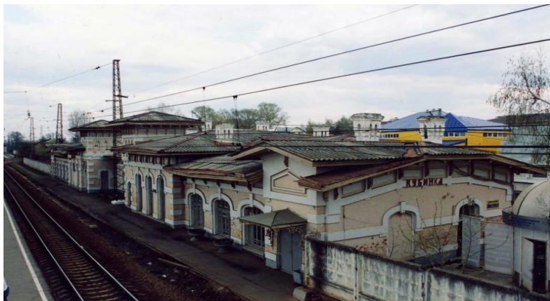
Рис. 6. Железнодорожная станция Кубинка.
