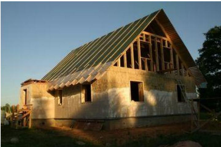
Рис. 10. Оштукатуренный глиной экодом.
