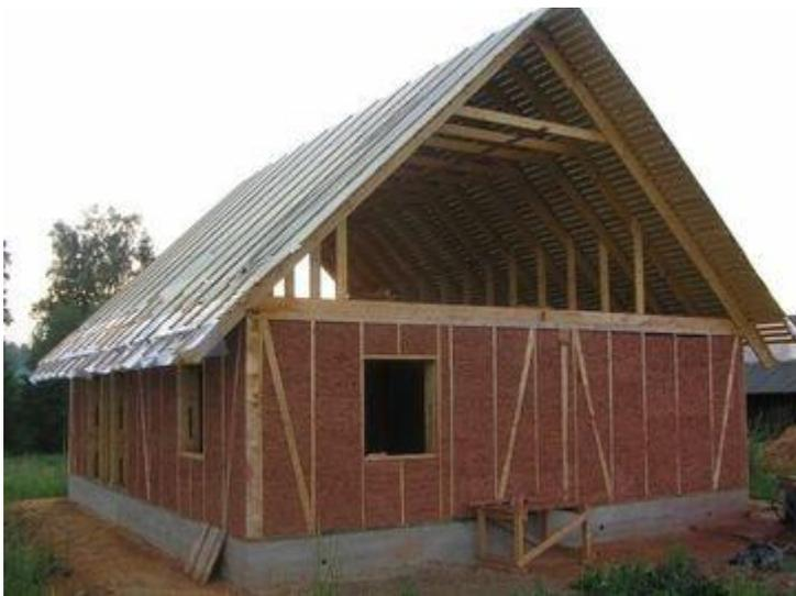
Рис. 7 Стены каркасного дома.
