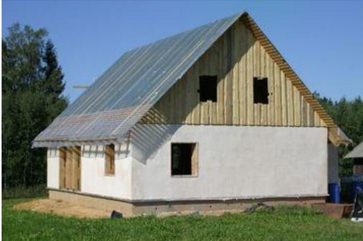
Рис. 11. Начальный этап глиняно-соломенной кровли.
