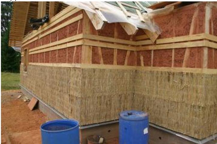
Рис. 8. Утеплитель из соломы в стенах экодома.
